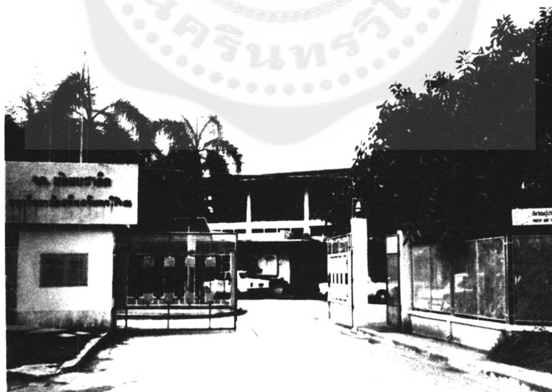
อาคารอำนวยการ
