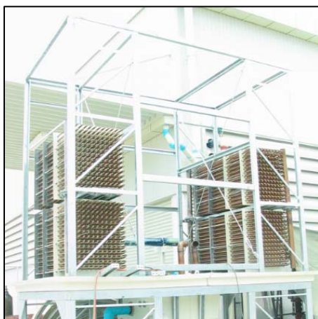
ภาพประกอบ 11 หอทำความเย็นแบบน้ำและอากาศไม่ได้สัมผัสโดยตรง (ระบบปิด)
