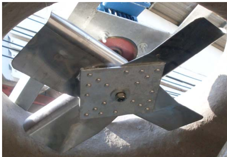
ภาพประกอบ 24 แสดงลักษณะของใบพัดในหอทำความเย็น
