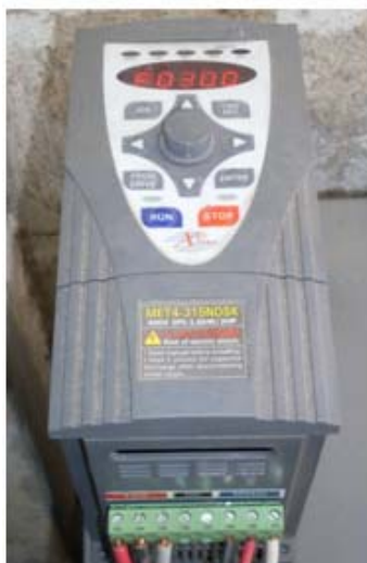
ภาพประกอบ 28 แสดงลักษณะเครื่องปรับรอบของมอเตอร์ขับเคลื่อนพัดลม
