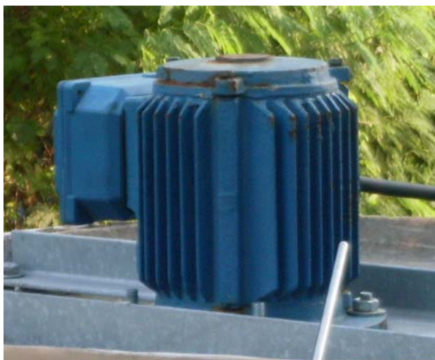
ภาพประกอบ 25 แสดงลักษณะของมอเตอร์ในหอทำความเย็น
