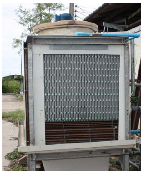
ภาพประกอบ 20 หอทำความเย็นรูปแบบการจัดวางแผงกระจายละอองน้ำแบบเดิม
