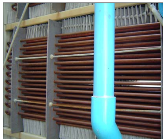
ภาพประกอบ 11 หอทำความเย็นแบบน้ำและอากาศไม่ได้สัมผัสโดยตรง (ระบบปิด)
