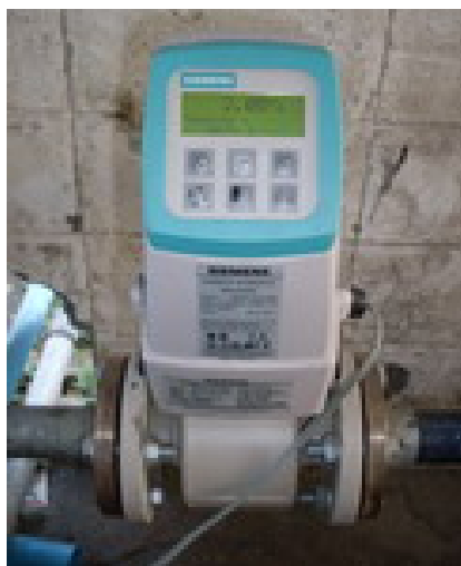
ภาพประกอบ 27 แสดงลักษณะเครื่องวัดอัตราการไหลของน้ำ
