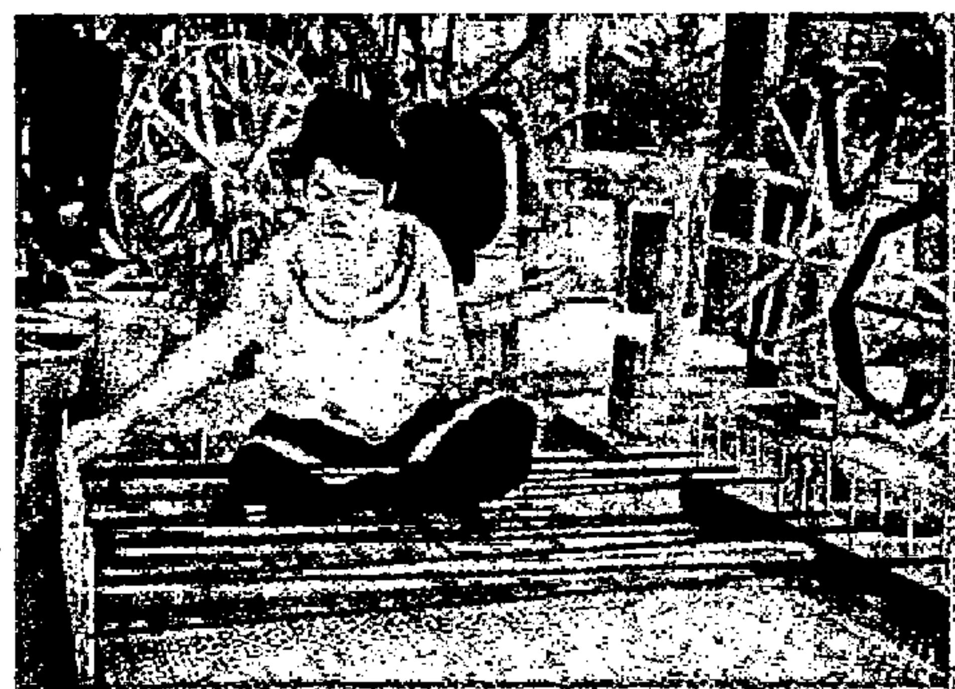
เรียงเส้นด้ายด้วยหลักเดินด้าย
