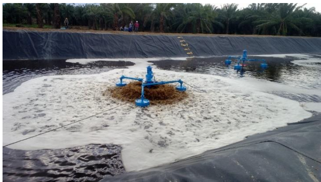
ภาพประกอบ 38 ระบบบำบัดน้ำเสียแบบเติมอากาศ (Aerated lagoon)
