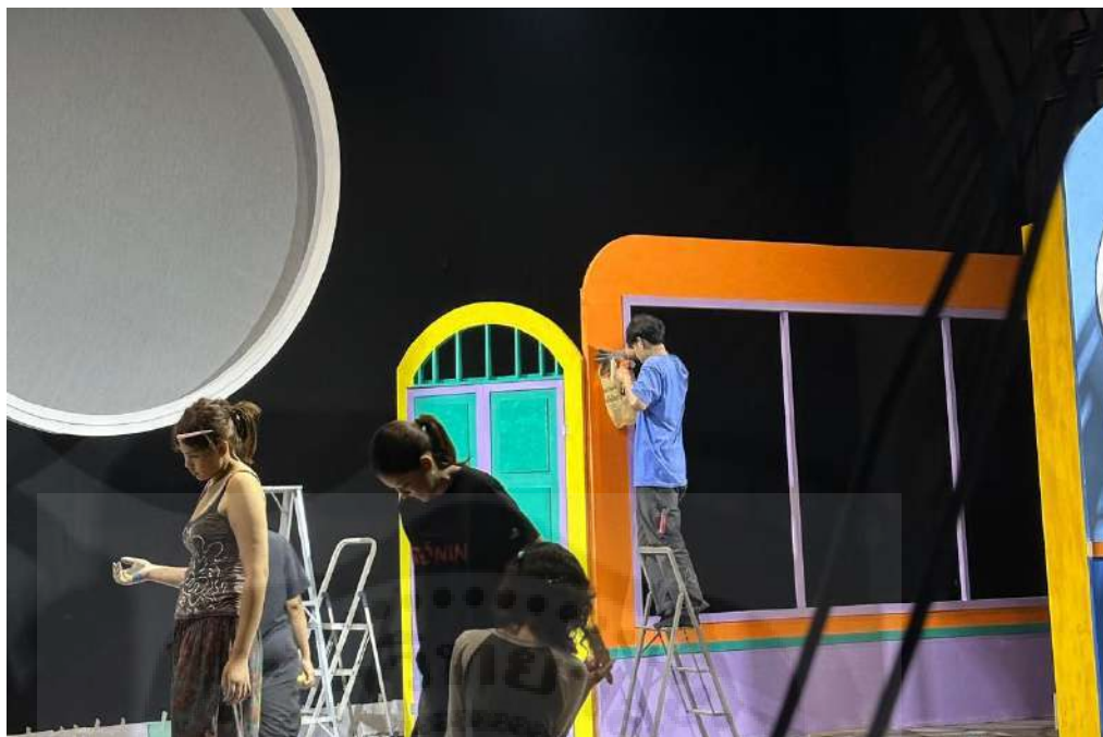
ภาพที่ 3.89: ภาพการติดตั้งไฟกริ่ง
