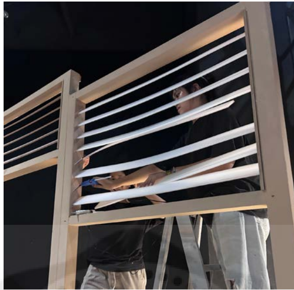
ภาพที่ 3.27 : ภาพขณะติดตั้งระแนง
