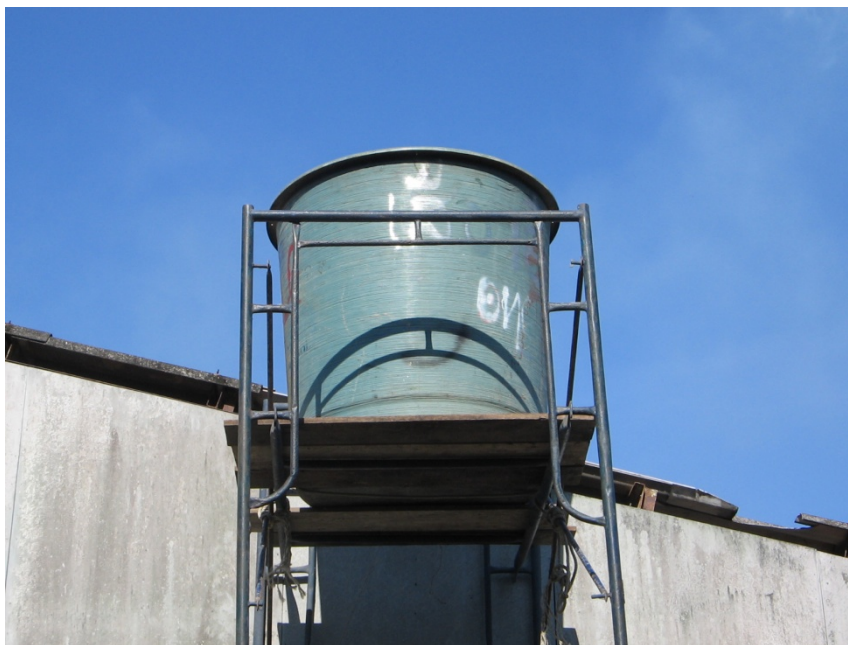
ภาพประกอบ 15 ถังจ่ายน้ำที่ใช้ในการทดสอบ ขนาด 1000 ลิตร
