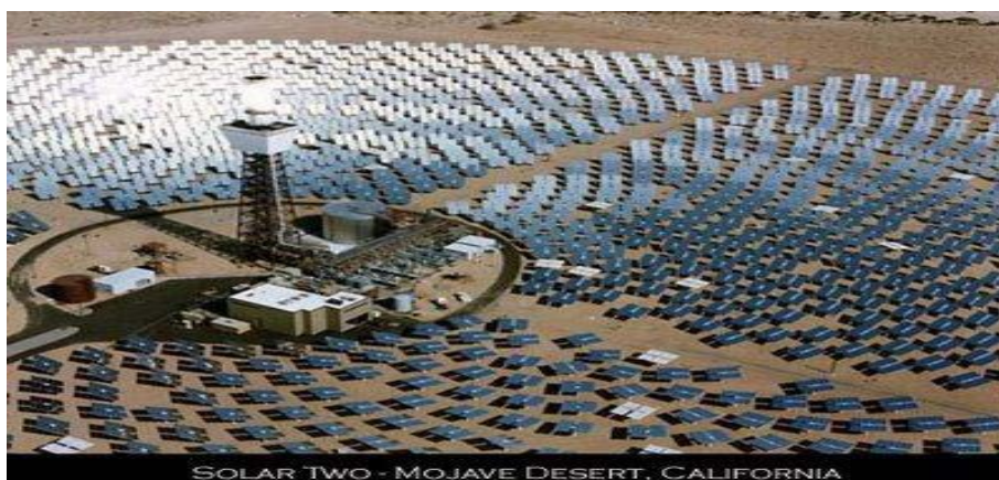
ภาพประกอบ 7 Solar Tower
