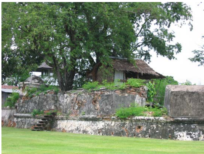
ภาพประกอบ 44 บันไดไม้ที่ทำไว้เพื่อเป็นทางเข้าไปบ้านพักของพนักงานและคนงานก่อสร้าง ไม่เหมาะสมที่จะนำมาวางพาดไว้ที่กำแพง
