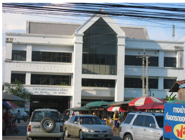
ภาพประกอบ 36 อาคารที่จอดรถสร้างขึ้นใหม่ สามารถจอดรถได้ 350 คัน
