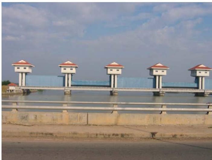
ภาพประกอบ 14 ช่องระบายน้ำที่ติดตั้งประตูระบายน้ำจำนวน 5 ช่อง สามารถชมได้จาก สะพานข้ามแม่น้ำบางปะกง ที่อยู่บริเวณเขื่อนทดน้ำบางปะกง
