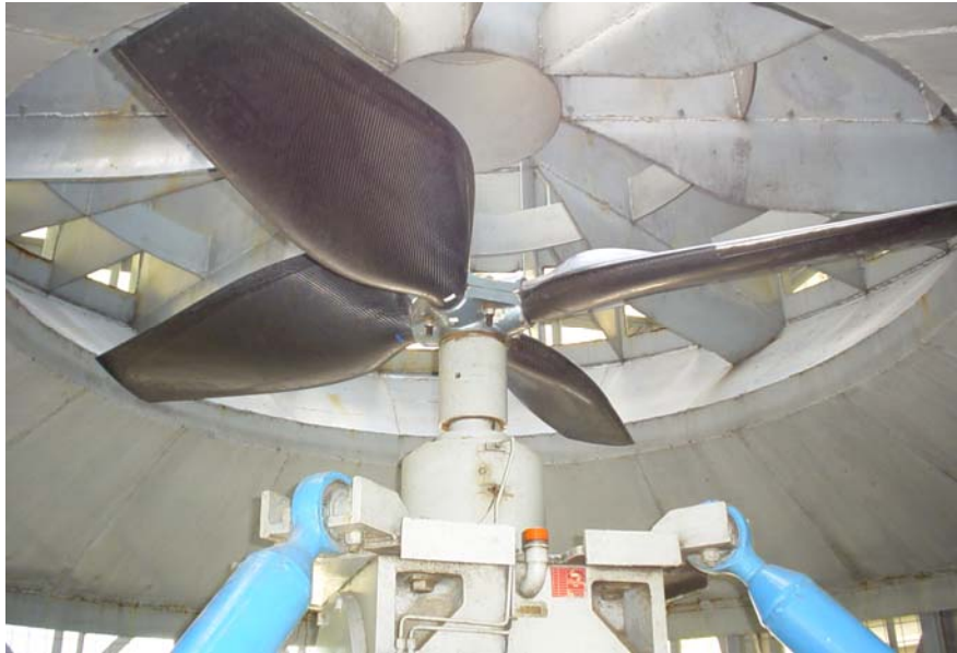
ภาพประกอบ 7 แสดงชุดใบพัดลมเครื่องช่วยฝึกเทคโนโลยีสูงอุโมงค์ลมทางดิ่ง 1
