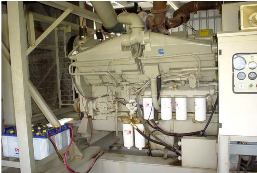
ภาพประกอบ 8 แสดงชุดเครื่องยนต์ดีเซล 12 สูบ ต้นกำลังของเครื่องช่วยฝึกเทคโนโลยีสูงอุโมงค์ลมทางดิ่ง 1
