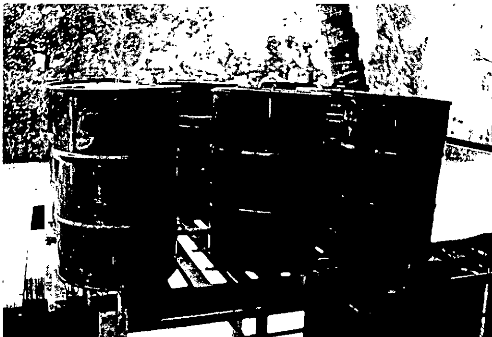
ภาพประกอบ 17 ภาพถังหมักแบบไม่ใช้ออกซิเจน (Anaerobic Filter)
