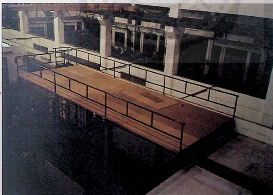
รูปที่ 4.7 ปูไม้ฉลบบนคานชอยเพื่อทำเป็นพื้นชั้นลอยเอนกประสงค์
