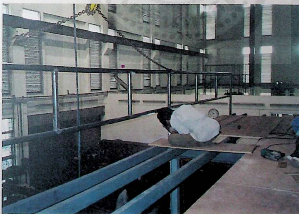
รูปที่ 4.5 เชื่อมราวแล้วนำขึ้นไปติดกับชั้นลอยเอนกประสงค์
