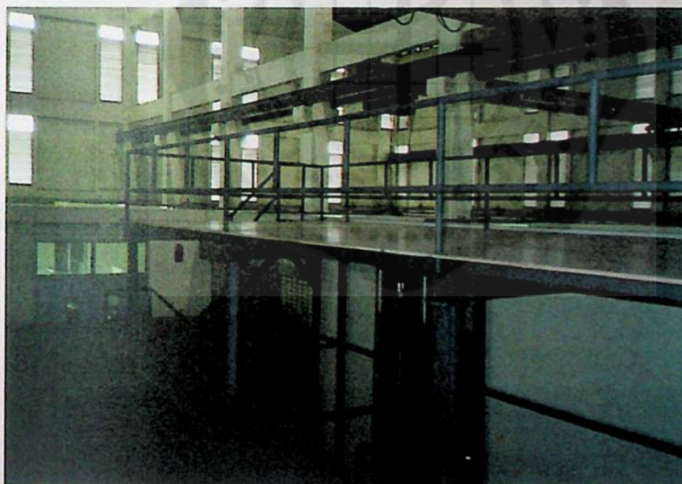
รูปที่ 4.10 ชั้นลอยเอนกประสงค์ที่เสร็จสมบูรณ์แล้ว
