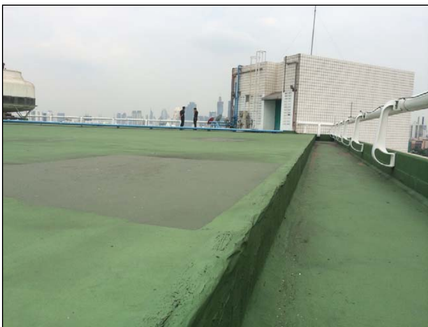
ภาพประกอบ 48 บริเวณพื้นที่บนชั้นดาดฟ้าอาคารเซลล์เฮาส์ ภาพ 2
