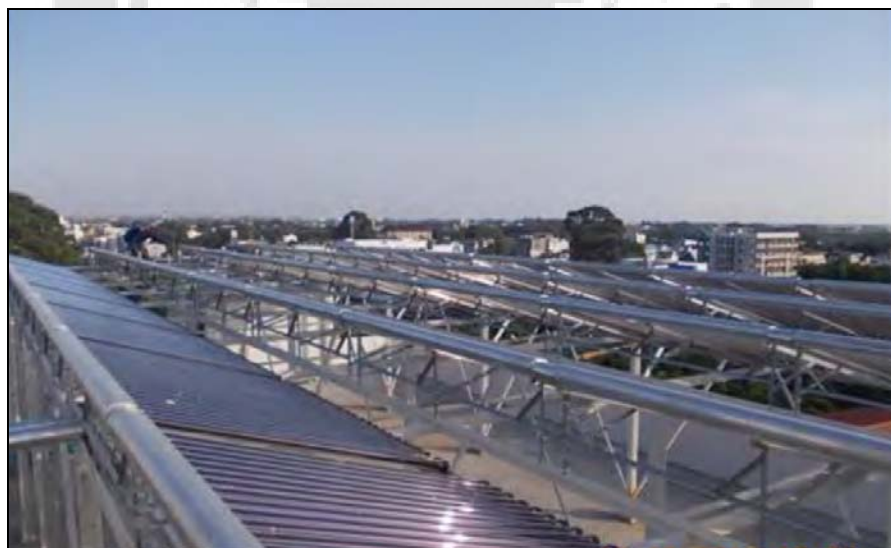
ภาพประกอบ 55 ตัวอย่างการติดตั้งตัวเก็บรังสีอาทิตย์ ภาพ 2
