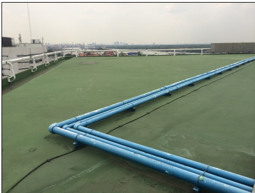
ภาพประกอบ 50 บริเวณพื้นที่บนชั้นดาดฟ้าอาคารเซลล์เฮาส์ ภาพ 4
