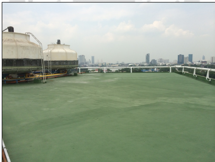
ภาพประกอบ 51 บริเวณพื้นที่บนชั้นดาดฟ้าอาคารเซลล์เฮาส์ ภาพ 5
