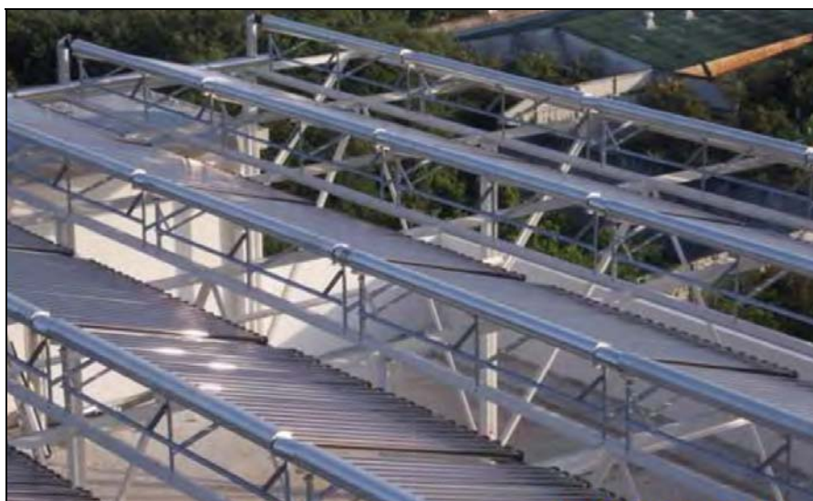
ภาพประกอบ 54 ตัวอย่างการติดตั้งตัวเก็บรังสีอาทิตย์ ภาพ 1
