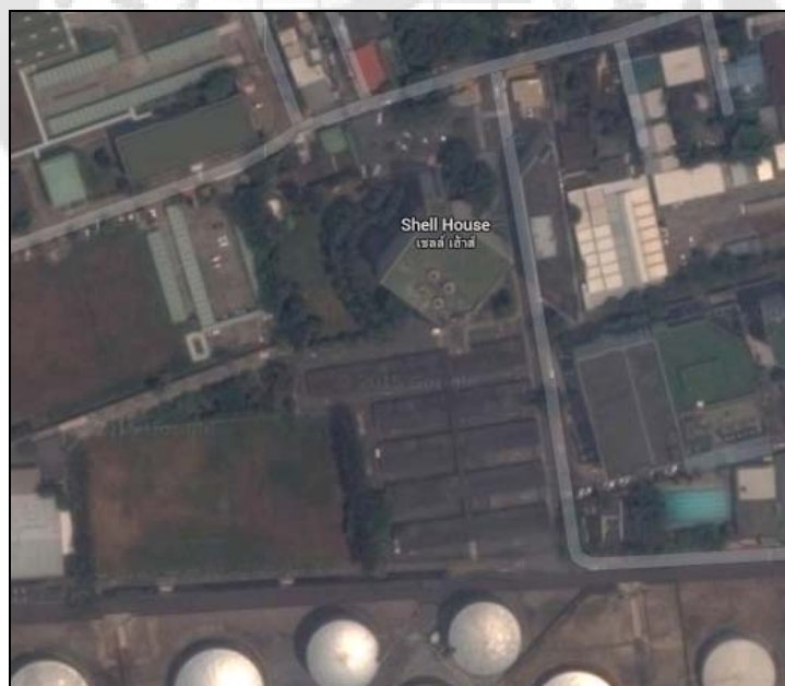
ภาพประกอบ 28 พื้นที่ด้านบนบริเวณโดยรอบอาคารเชลล์เฮาส์
