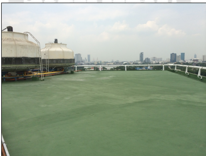
ภาพประกอบ 49 บริเวณพื้นที่บนชั้นดาดฟ้าอาคารเซลล์เฮาส์ ภาพ 3
