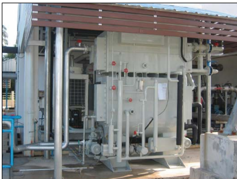
ภาพประกอบ 52 ตัวอย่างเครื่องทำน้ำเย็นแบบดูดกลืนโดยใช้ระบบทำน้ำร้อนด้วยรังสีอาทิตย์
