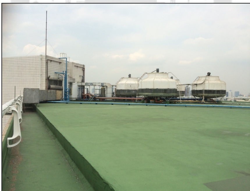
ภาพประกอบ 47 บริเวณพื้นที่บนชั้นดาดฟ้าอาคารเซลล์เฮาส์ ภาพ 1
