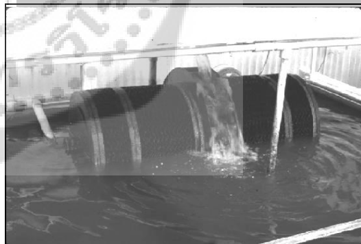
ระบบบำบัดน้ำเสียแบบจานหมุนชีวภาพ (ที่มา ; www.edie.net , www.ag.arizona.edu )
