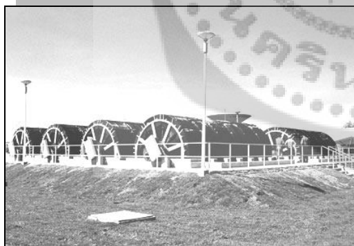
ระบบบำบัดน้ำเสียแบบจานหมุนชีวภาพ (ที่มา ; www.edie.net , www.ag.arizona.edu )
