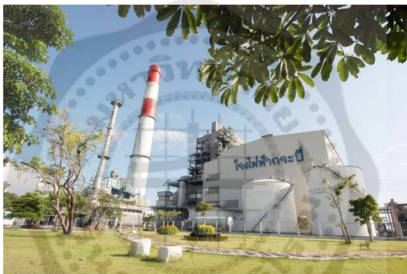
ภาพประกอบ 18 โรงไฟฟ้ากระบี่ จังหวัดกระบี่
