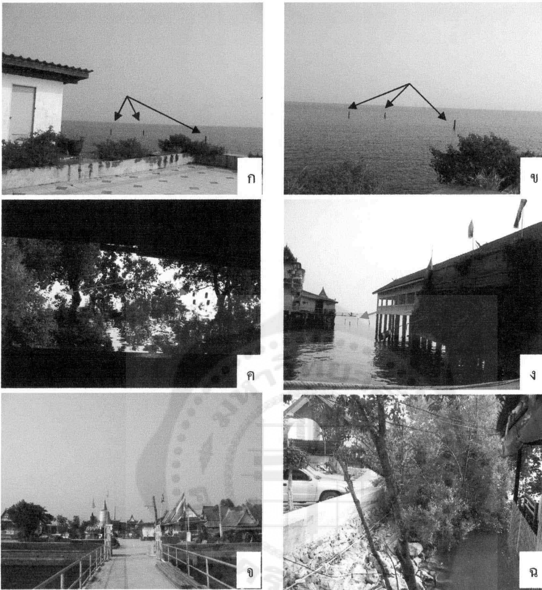
รูปที่ 3.7 ภาพแสดงเขื่อน และสิ่งก่อสร้างเพื่อป้องกันน้ำท่วม ซึ่งบริเวณที่เป็นพื้นน้ำเคยเป็นที่ตั้งบ้านเรือนของราษฎร
