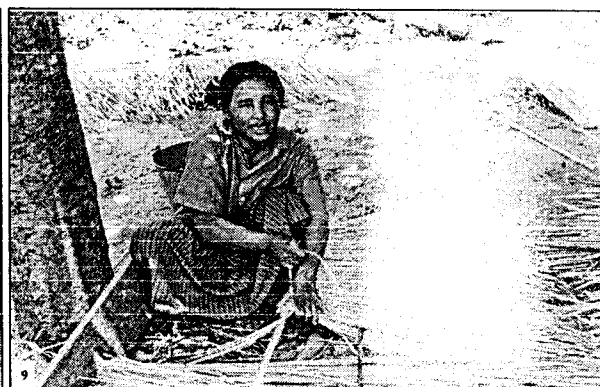
ภาพประกอบ 10 การทำวัสดุถุงหลังคา ทำจากหญ้าคา
