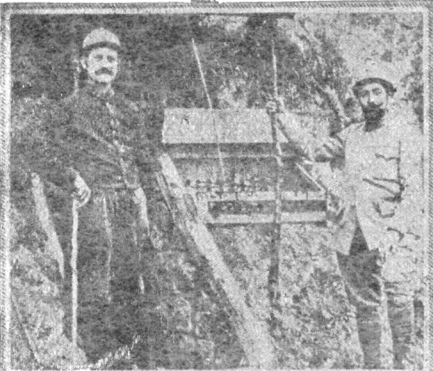
รูปที่ ๕— ที่ต่อสายโทรศัพท์ โถงแนวหน้า.
