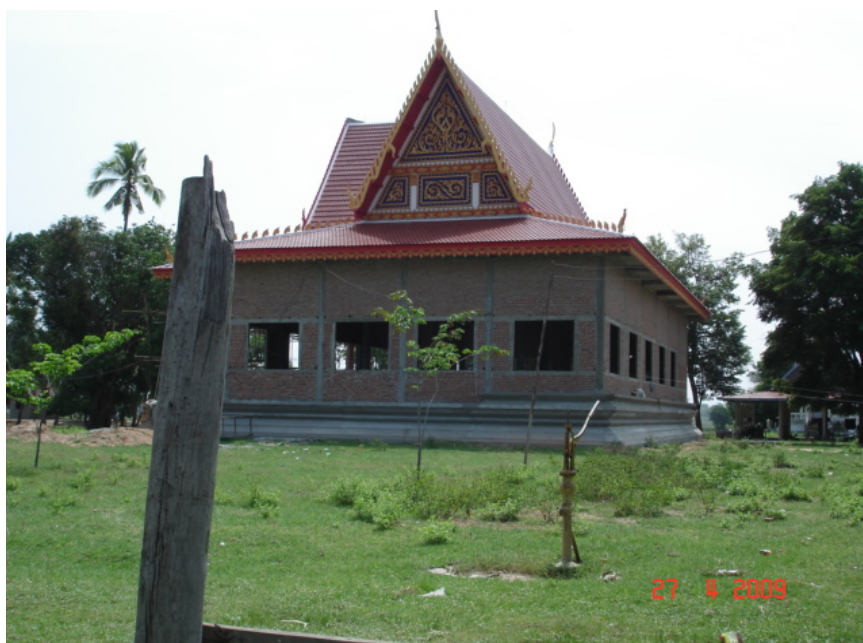
ภาพประกอบ 11 ศาลาการเปรียญที่กำลังก่อสร้าง วัดแสงสว่างอารมณ์
