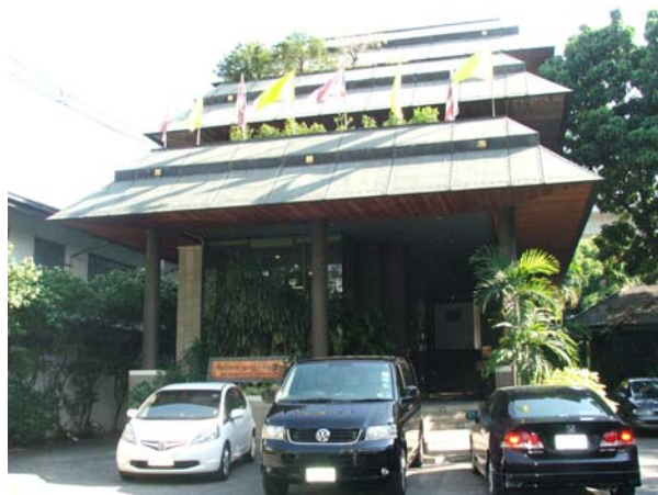
ภาพประกอบ 16 อาคารศิลปาคารจุมภฏ-พันธุ์ทิพย์ (บันทึกภาพเมื่อวันที่ 6 มีนาคม 2553)
