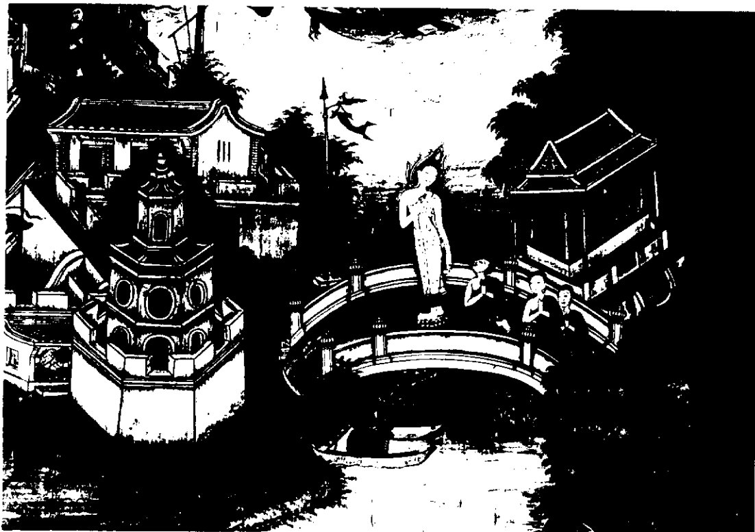
ภาพประกอบ 60 สะพานข้ามคลอง สร้างด้วยการก่ออิฐถือปูน
