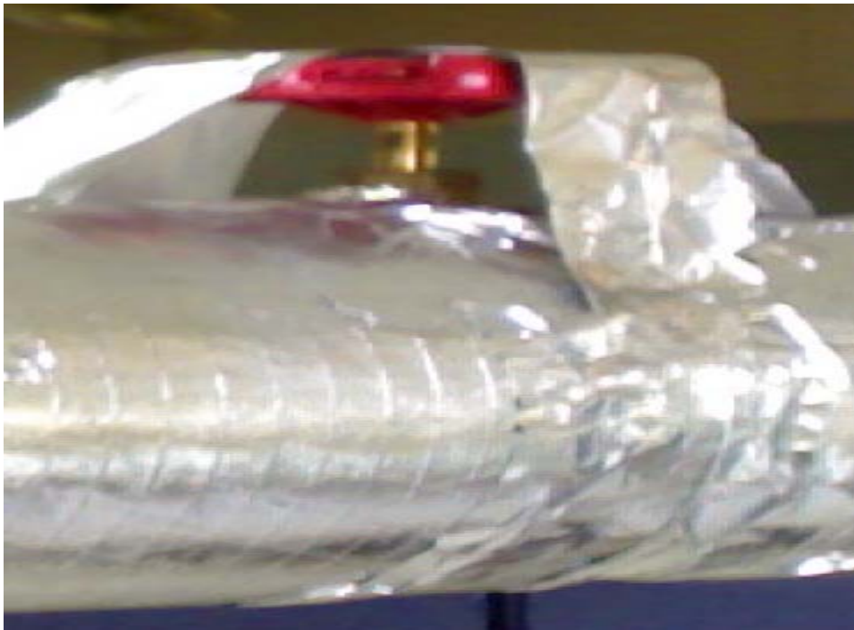
ภาพประกอบ 4 วาล์วปรับอัตราการไหล (Globe valve)
