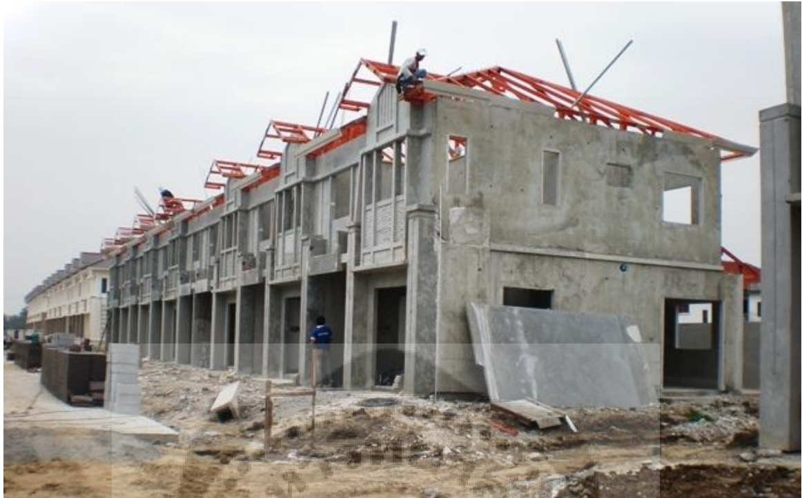
ภาพประกอบ 9 แสดงตัวอย่างผนังคอนกรีตสำเร็จรูปโครงการบ้านจัดสรร
