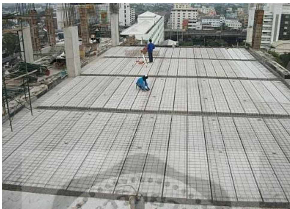
ภาพประกอบ 8 แสดงตัวอย่างแผ่นพื้นคอนกรีตสำเร็จรูปที่ใช้ในโครงการก่อสร้าง
