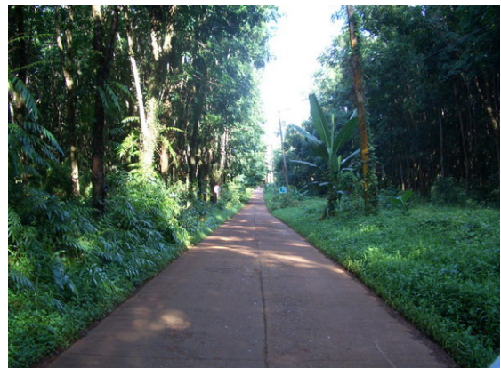
ถนนคอนกรีต
