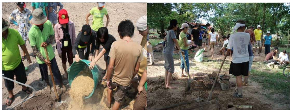
ภาพประกอบ 35 เตรียมดินไว้เพื่อนำไปผสมกับส่วนผสมอื่นๆ ในหลุมที่ขุดเพื่อเตรียมย่ำดิน
