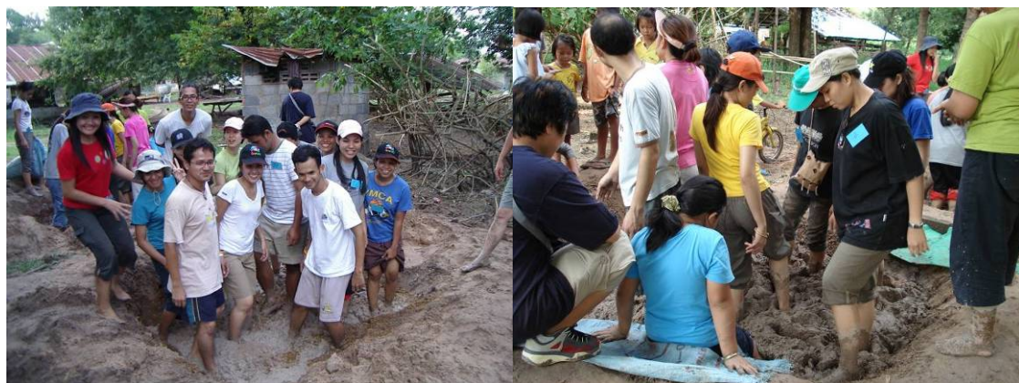
ภาพประกอบ 36 ย่ำดินเพื่อเตรียมดินมาอัดเป็นบล็อก ให้เป็นอิฐดิน
