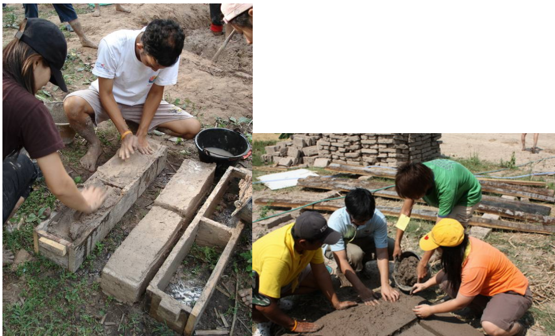
ภาพประกอบ 37 สภาพของดินที่เริ่มจับตัวกันและนำมาใส่ในบล็อกไม้แบบ เพื่อทำเป็นอิฐดิน
