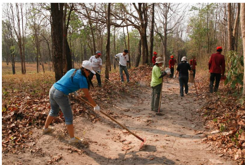
ภาพประกอบ 29 แนวกันไฟที่ใกล้จะเสร็จสมบูรณ์
