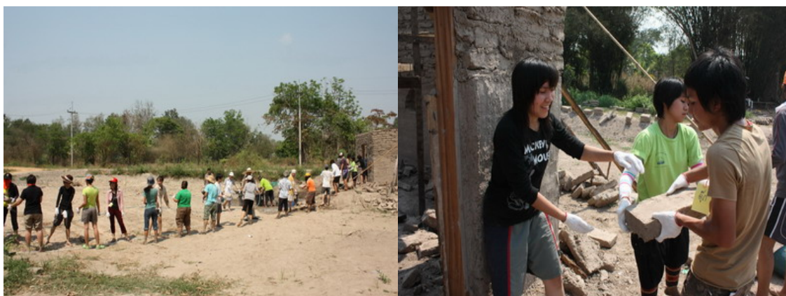
ภาพประกอบ 38 ยืนต่อแถวเพื่อส่งอิฐดิน นำมาก่อเป็นบ้านดิน
