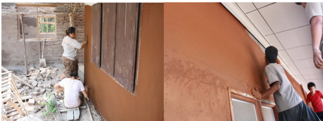
ภาพประกอบ 40 นำดินละเอียดมาฉาบผนังบ้านดิน
