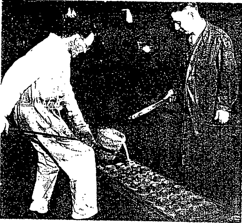
ภาพประกอบ 39 แสดงลักษณะการเทน้ำโลหะด้วยเบ้าเทมือ
