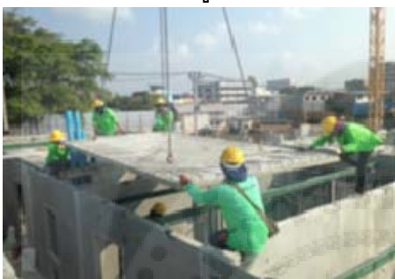
พื้นคอนกรีตสำเร็จรูป
