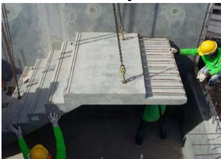
ภาพประกอบ 87 การติดตั้งโครงสร้างชิ้นส่วนสำเร็จรูปและการแสดงในแบบจำลองสารสนเทศ
