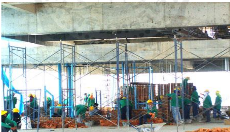
ภาพประกอบ 10 กระบวนการก่อสร้างที่ต้องใช้แรงงานมากกว่าระบบขึ้นสำเร็จรูป
