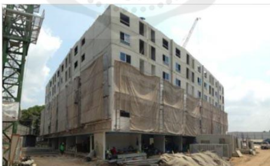
ภาพประกอบ 16 โครงการก่อสร้างอาคารที่เป็นระบบชิ้นส่วนคอนกรีตสำเร็จรูป
