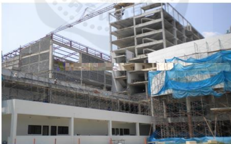
ภาพประกอบ 6 งานก่อสร้างระบบคอนกรีตเสริมเหล็กทั่วไปซึ่งเป็นการเข้าแบบหล่อ เทคอนกรีตในที่และระบบผนังเป็นการก่ออิฐฉาบผิวตกแต่งผนัง
