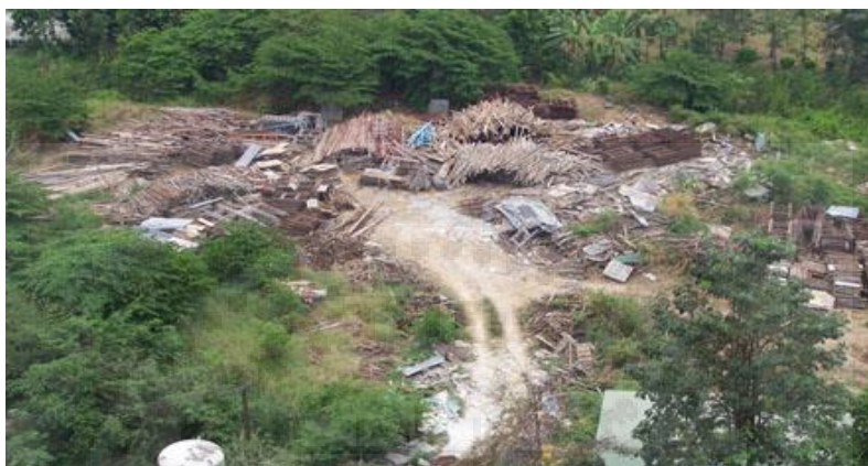
ภาพประกอบ 13 เศษไม้แบบค้ำยันจากการใช้งานหล่อคอนกรีตในที่
