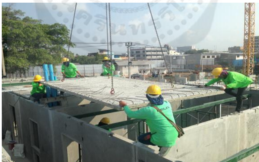
ภาพประกอบ 18 การดำเนินการติดตั้งพื้นชิ้นส่วนคอนกรีตสำเร็จรูป
