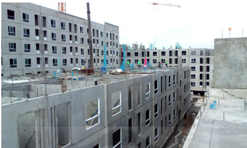
ภาพประกอบ 20 กระบวนการติดตั้งที่เป็นระบบสำเร็จรูปช่วยลดปริมาณขยะและฝุ่นละออง
