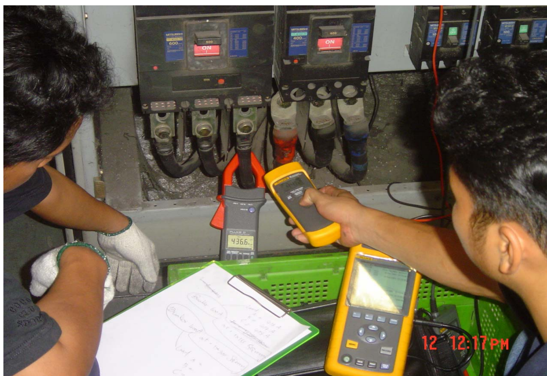
ภาพประกอบ 15 แสดงเครื่องมือสำหรับการตรวจวัดและเก็บข้อมูลการใช้พลังงานไฟฟ้า
