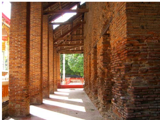
ภาพประกอบ 133 ผนังด้านซ้ายวิหารวัดเพลงวิปัสสนา อิฐบางส่วนแตกหักและหลุดออกจาก ฐาน
