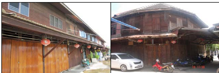
ภาพประกอบ 17 ลักษณะทางสถาปัตยกรรมของบ้านเก่าเหล้าเต็งไม้
