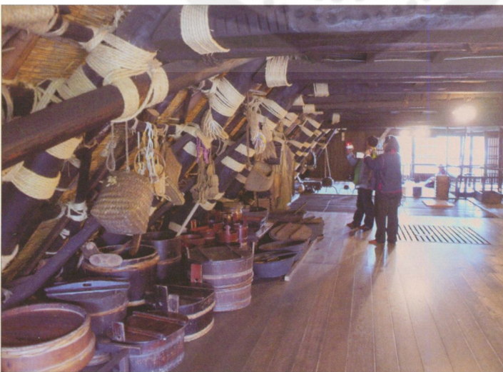
ภายในตัวบ้าน ชั้นบนสุดห้องใต้หลังคา จะสังเกตการผูกเครื่องมืองหลังคาแทนการตอก
