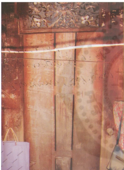
ประตู นิยมทำบานเดียว บางทีจะทำเป็นประตูหลอก โดยใส่ อกละให้ดูคล้ายประตูสองบาน (ไม่นิยมทำประตูสองบาน เพราะจะไปคล้ายกับวัด คือ โบสถ์ วิหารนั่นเอง) สลักประตู จะอยู่ข้างประตู สำหรับเสียบกับบานประตู แล้วเสียบไม้กัน ไม่ให้หลุดจากบานประตู
