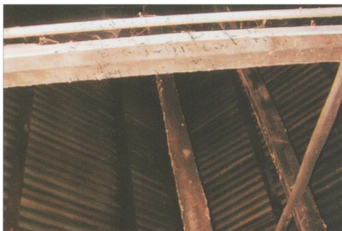
ช่วยยัน ไม้ที่พาดกับเสาโดน เพื่อสะดวกในการ ขึ้นซ่อมแซมหลังคา
