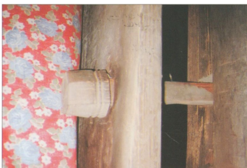
สลักประตู เมื่อเข้าไปในห้องแล้ว จะดันบาน ประตูซึ่งเจาะเป็นรูเข้ากับเดือยสลักประตูแล้ว ใช้ไม้เสียบที่รูไม้สลักประตูอีกครั้งหนึ่ง
