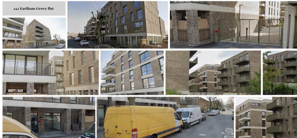
ภาพที่ 3.10: ภาพรวมภายนอกอาคารแฟลต
