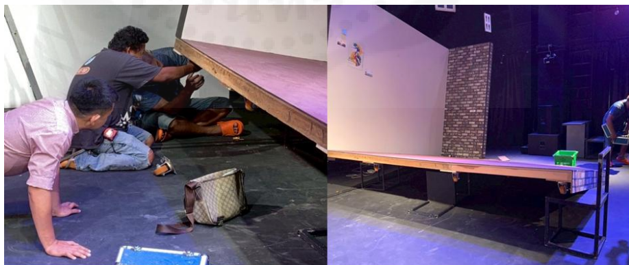
ภาพที่ 3.36: ภาพรวมในการเปลี่ยนล้อสำหรับการเลื่อน
