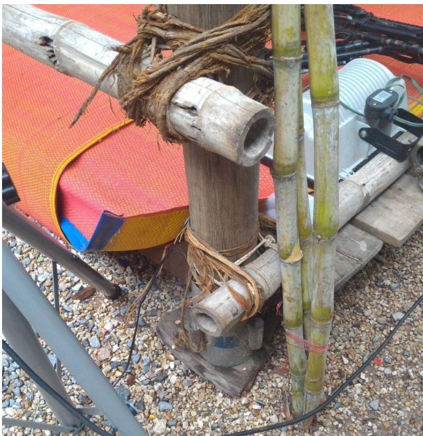
ภาพประกอบ 23 เสาโรงครูทำจากไม้หมาก (ภาพถ่าย 9 กันยายน 2558 โดย ผู้วิจัย)
