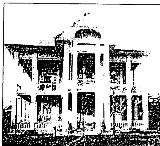
ภาพแสดงอาคารเรียนในอดีต
