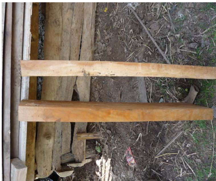
ภาพประกอบ 16 การเตรียมไม้ในการทำพิน (ความหนาของไม้)
