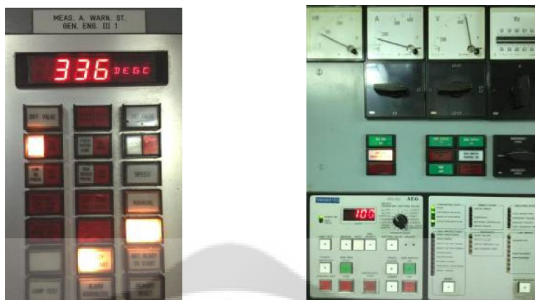
ภาพประกอบ 49 ระบบควบคุมและแสดงผลของเครื่องยนต์ดีเซลกำเนิดไฟฟ้า
