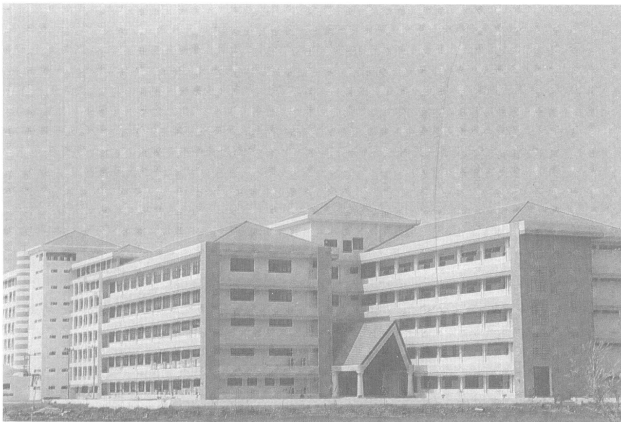
อาคารเรียนรวม
