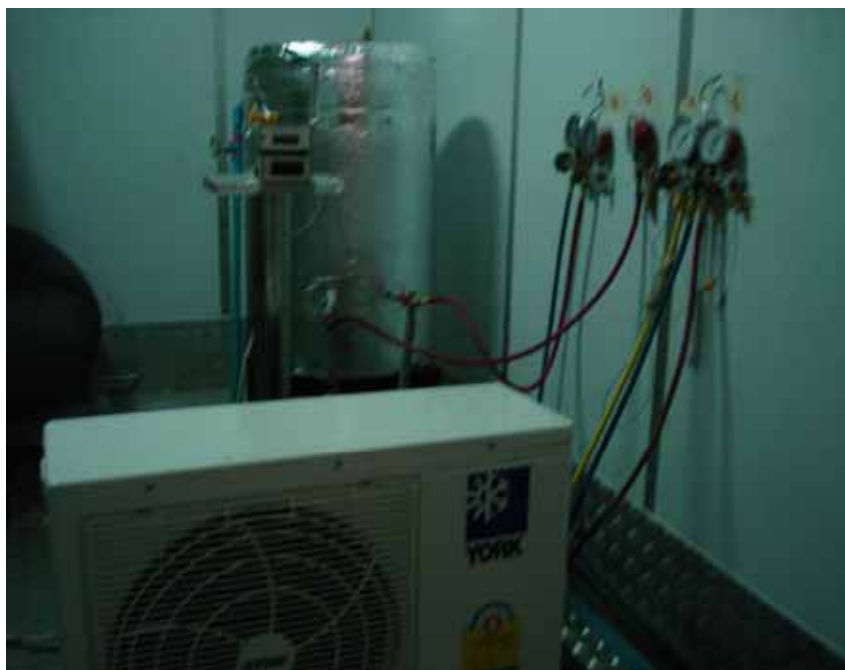
ภาพประกอบ 16 การติดตั้งท่อน้ำเข้า - ออก ท่อสารทำความเย็นและถึงน้ำแสดงอุณหภูมิด้วยฉนวน เพื่อป้องกันความร้อนที่สูญเสีย
