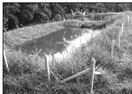
ภาพประกอบ 15 แสดงระบบบำบัดแบบบ่อฝัง (ทีมา ; www.griffith.nsw.gov.au , www.boervally.com )
