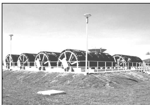
ภาพประกอบ 16 แสดงระบบบำบัดน้ำเสียแบบจานหมุนชีวภาพ (ที่มา ; www.edie.net , www.ag.arizona.edu )
