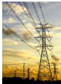
โครงเสาไฟฟ้าแรงสูง
