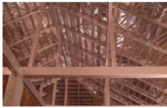
โครงหลังคา
