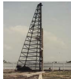
โครงปั้นจั่นยกลูกตุ้มตอกเสาเข็ม
