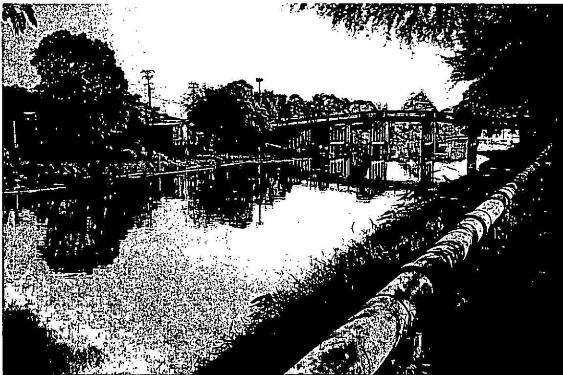
ท่อประปาที่วางไปตามแนวคลอง
