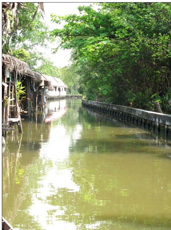
ภาพประกอบ 41 แสดงเขื่อนเล็กกันน้ำหนุนจากอีกฝั่งของคลอง
