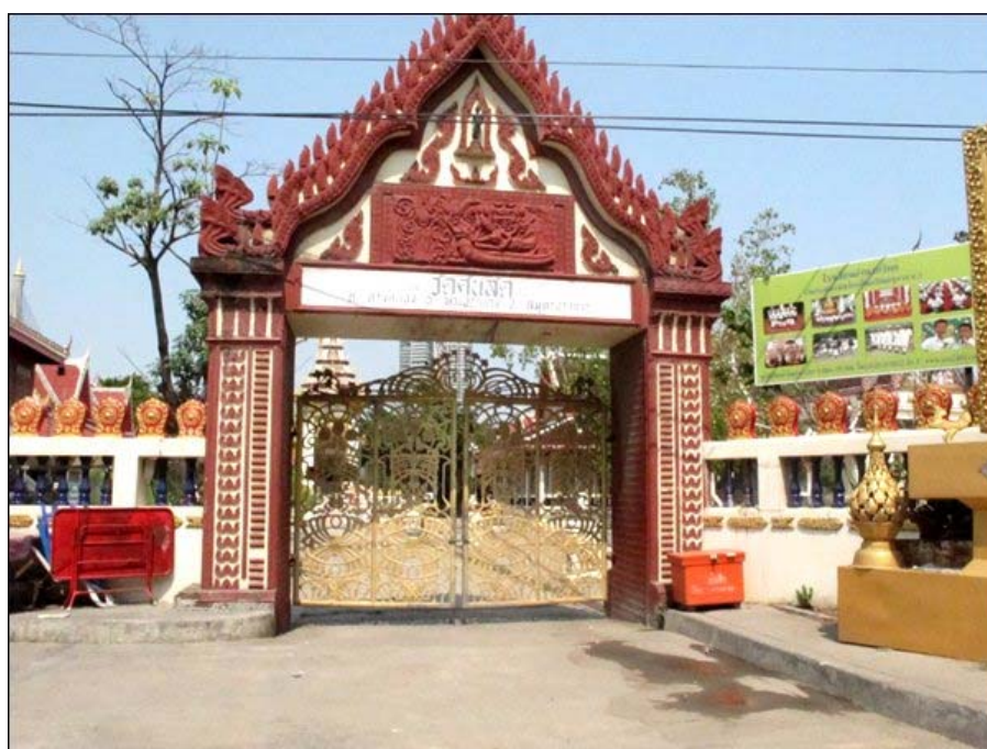
ภาพประกอบ 43 แสดงวัดคันลัดบริเวณทางเข้าตลาดน้ำบางน้ำผึ้ง
