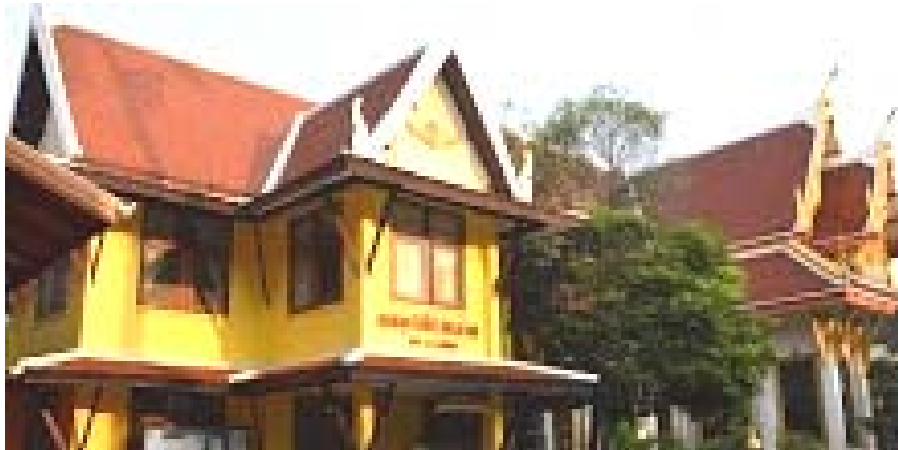
ภาพประกอบ 54 หอพระไตรปิฎก อาคารไม้ 2 ชั้น หลังคาทรงไทย 3 มุข เป็นลักษณะงานสถาปัตยกรรมที่ออกแบบอย่างสวยงาม
