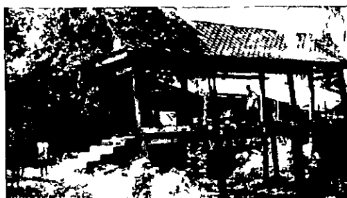
ภาพประกอบ 4 สะพานแบบมีหลังคา (ศิริชัย นฤมิตรเรขการ 2520 18)
