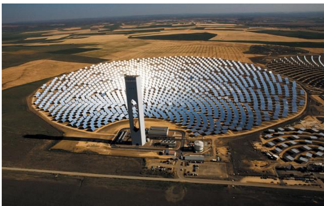
ภาพประกอบ 38 ภาพมุมสูงของโรงไฟฟ้าพลังงานความร้อนจากแสงอาทิตย์ขนาด 11 MW
