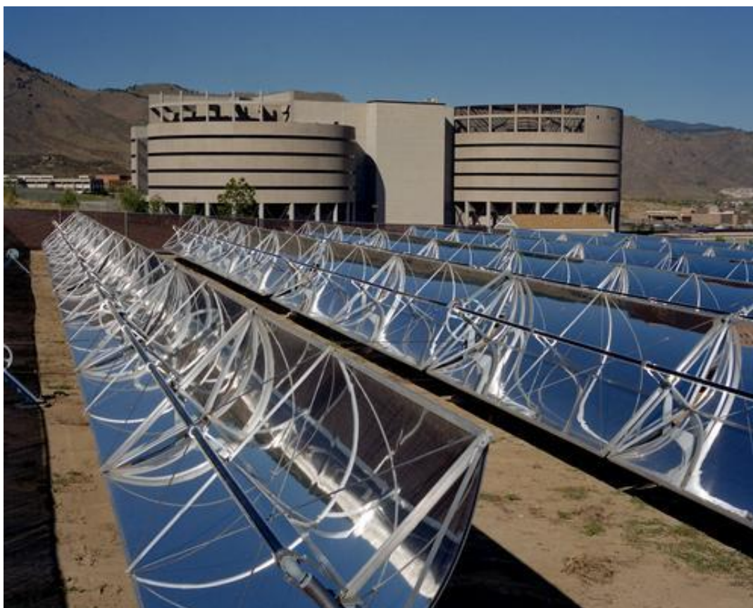
ภาพประกอบ 31 รังรวมแสงรูปพาราโบลิก (Parabolic Troughs)
