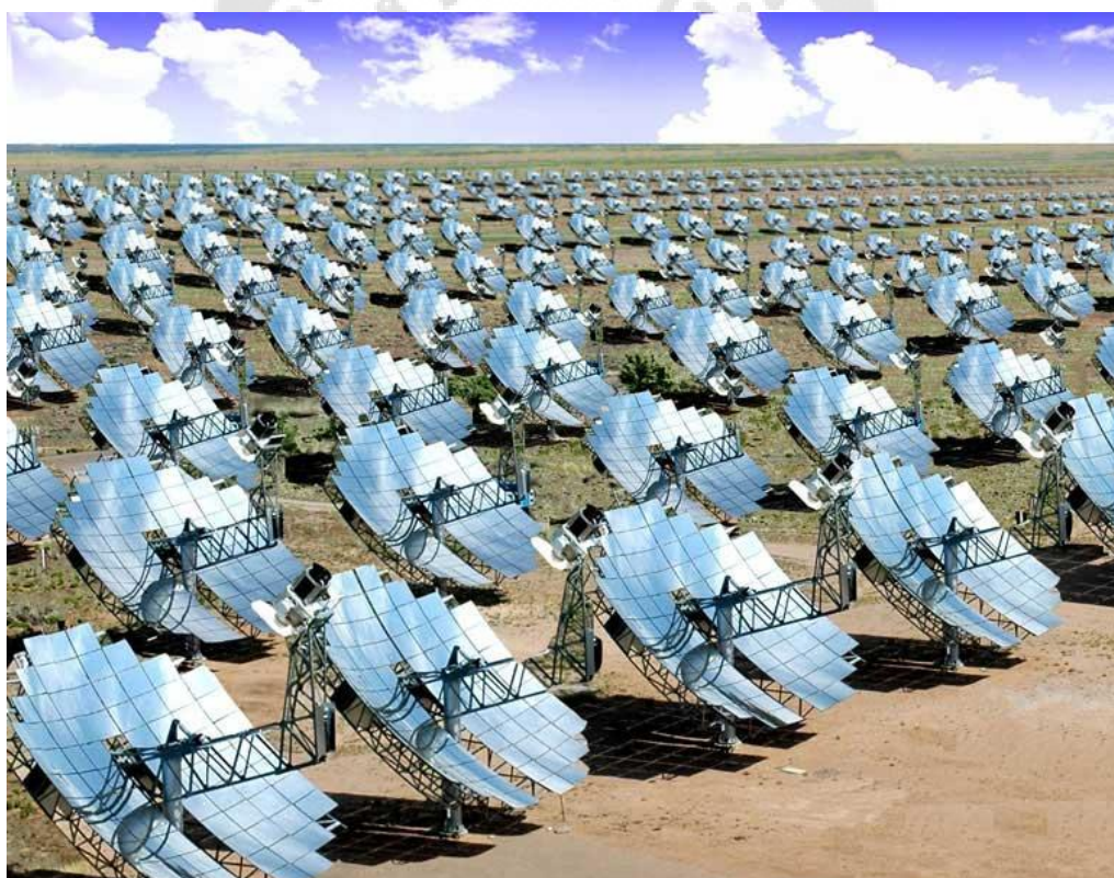
ภาพประกอบ 30 จานรวมแสง (Dish Plant)
