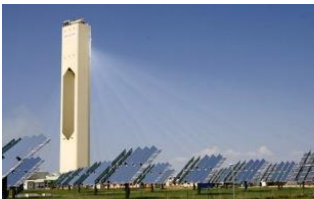
ภาพประกอบ 32 หอคอยรวมแสง (Tower Power Plants)
