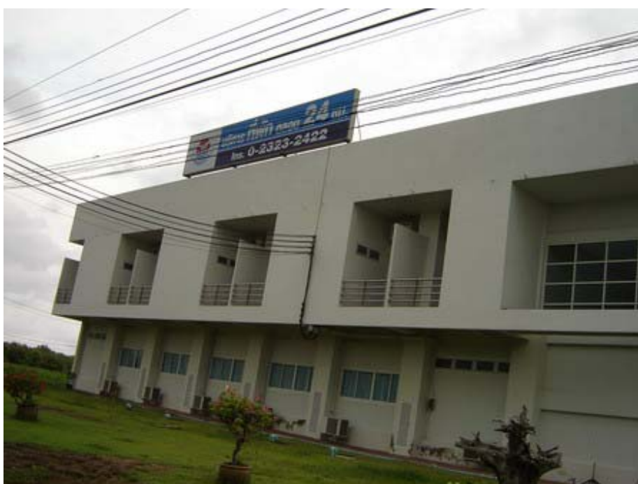
ภาพประกอบ 20 ภายนอกอาคารที่พักสถานตากอากาศบางปู
