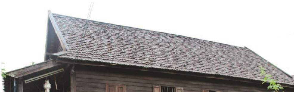
ภาพประกอบ 35 การมุงหลังคาด้วยแป้นเกล็ดไม้
