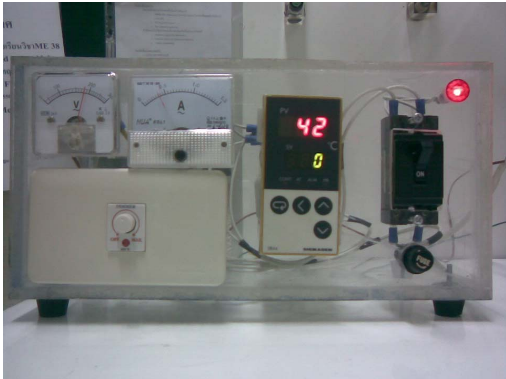
ภาพประกอบ 12 แสดงเครื่องควบคุมกำลังไฟฟ้าที่ป้อนให้ชุดลดความร้อน
