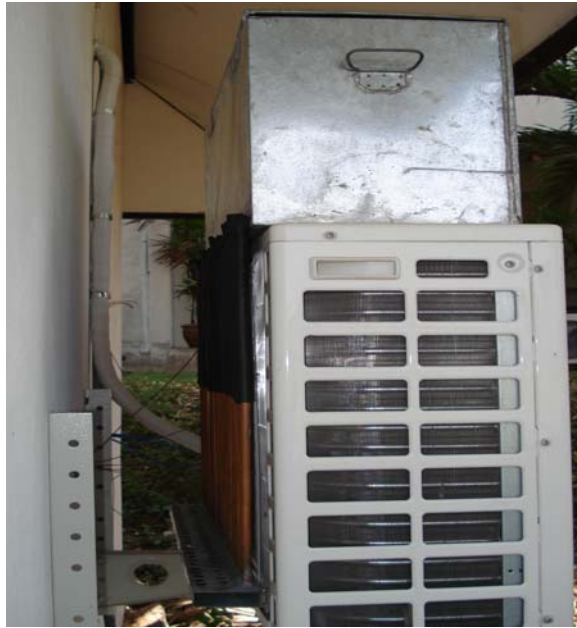
ภาพประกอบ 20 ชุดท่อความร้อนที่ประกอบเข้ากับชุดคอนเดนเซอร์
