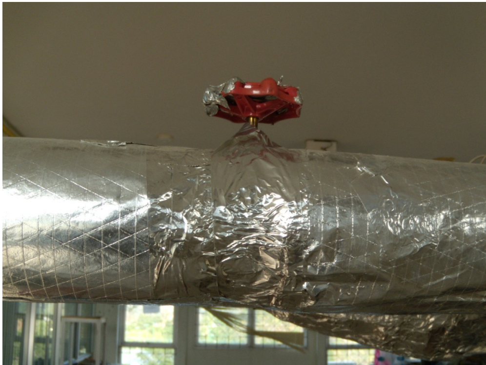
ภาพประกอบ 23 โกลบวาล์วสำหรับปรับอัตราการไหลของอากาศ
